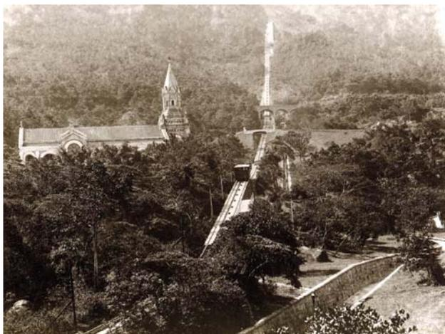
山頂纜車靠直徑 44 毫米及斷裂應力 139 公噸的鋼纜拉動，路軌軌距 1520 毫米，全程大部分地方均是單軌行駛，於中央位置，設有兩組路軌供兩部纜車交叉上落。山頂纜車由兩部鉸接式纜車以相反方向行走，每個小時可載 2,800 名人次。
