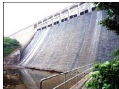
大潭篤水塘水壩為石面混凝土重力壩，長364 米、高49 米、中間位置設有12 條拱型溢洪道。壩底位置設有靜水池及行人橋，而壩頂則築有道路。水壩以層列花崗石砌成築有石面粗琢花崗石裝飾護牆。水壩中間10 條溢洪道加建了混凝土構築物，改為虹吸式溢洪道，其餘兩端的溢洪道則未予改動。
