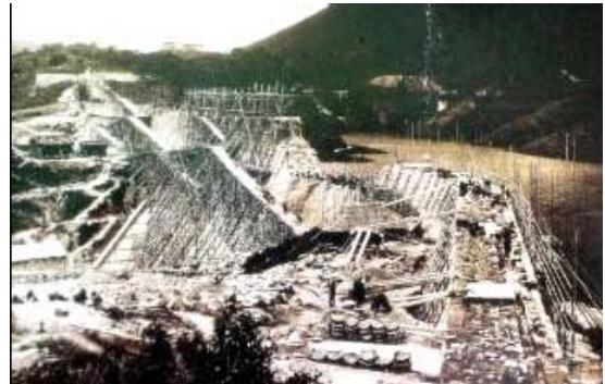
由於大部份港島地層屬花崗岩，當時建造技術還未完全機械化，故工程大都以人力及原始工具完成。在充滿山林瘴氣、人跡罕至之處挖掘隧道，其艱鉅程度可想而知。不少工人在興工期間更不幸染病死亡。另一方面，由於使用了抽水技術，大潭水塘的供水系統大都再不必因循由上而下的供水方法，在香港的食水供應史上，這可說向前邁進了一大步。
