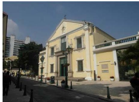
教堂正廳為一層，入口有夾層，是唱詩席。教堂坐北朝南，後部有鐘樓，與街道成一夾角，形成前地空間。教堂內有中廳和側廳，立面總高約 17 米。教堂中廳用木制拱頂，瓷磚地面。室內聖壇裝飾為巴洛克風格，表面為黃色粉刷。教堂立面簡樸，採用歐洲文藝復興時代的古典式構圖。入口用雙柱，是石制的羅馬塔斯干式，牆轉角處做有隅石狀，牆面為黃色粉刷，有許多卷渦形裝飾和白色線腳。屋頂為坡屋頂，瓦屋面，木屋架。教堂的主體結構為磚木結構，樓板為木樓板。
