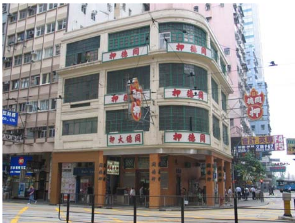
圖四 位於灣仔的同德大押，屬於舊粵式唐樓建築
